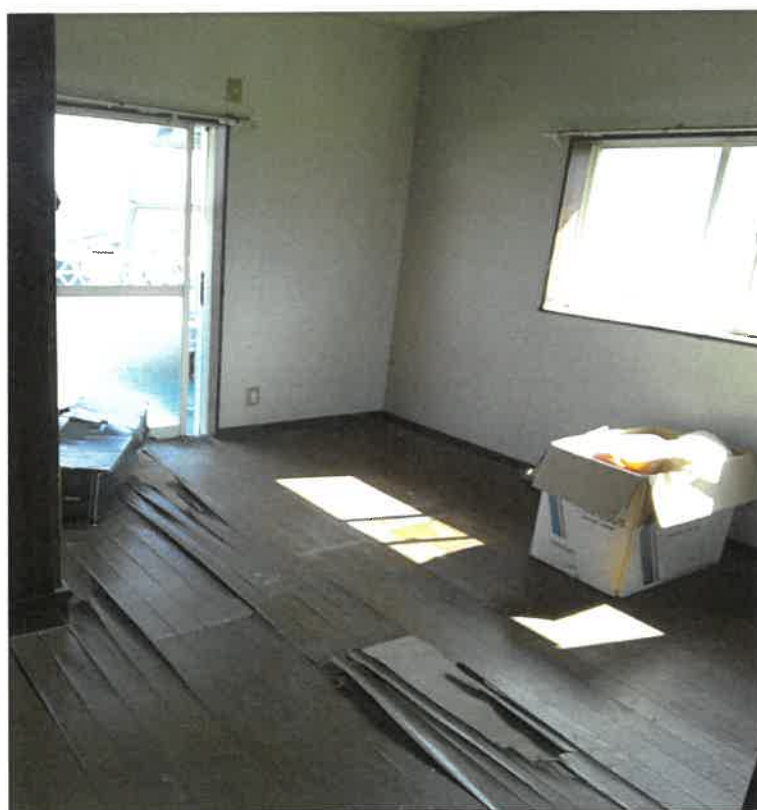
物件 1 2 階内部状況
