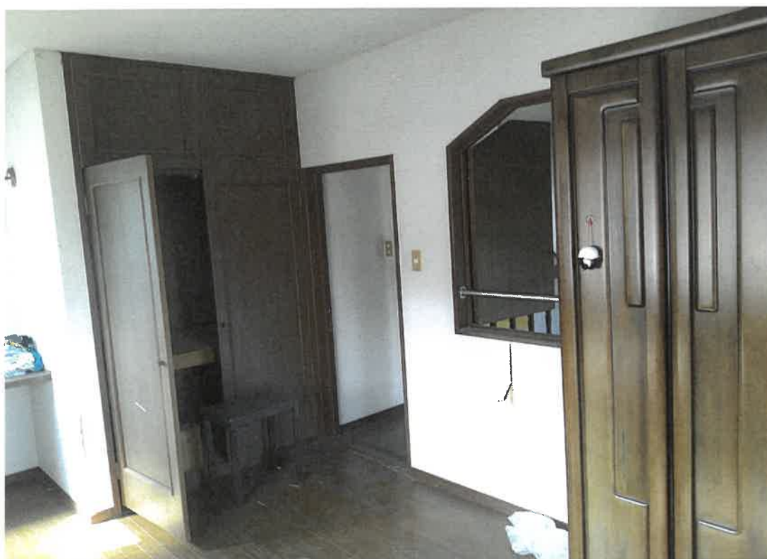
物件 1 2 階内部状況
