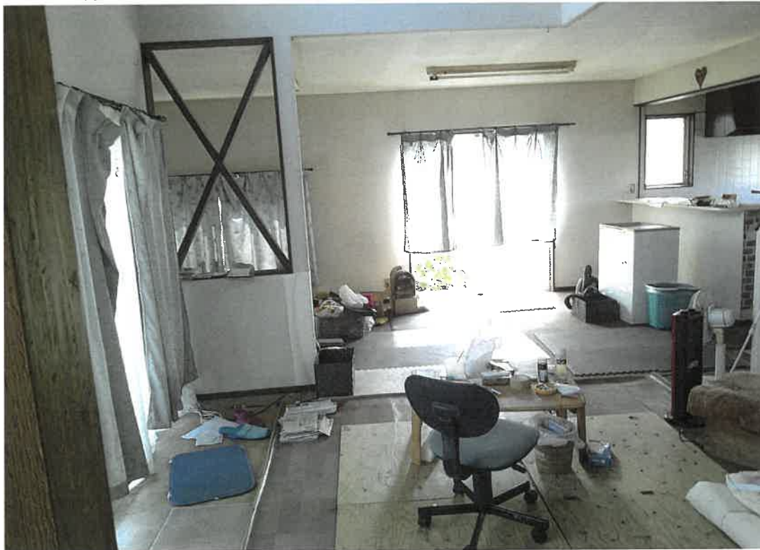
物件 1 1 階内部状況
