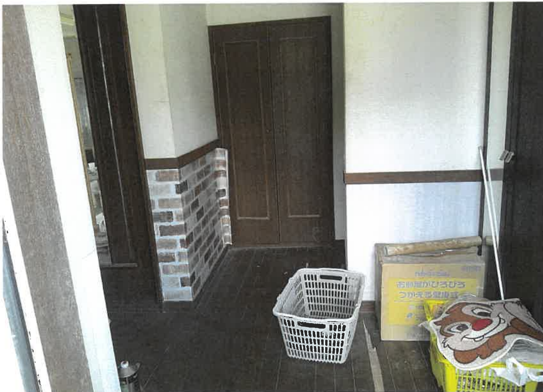
物件 1 1 階内部状況
