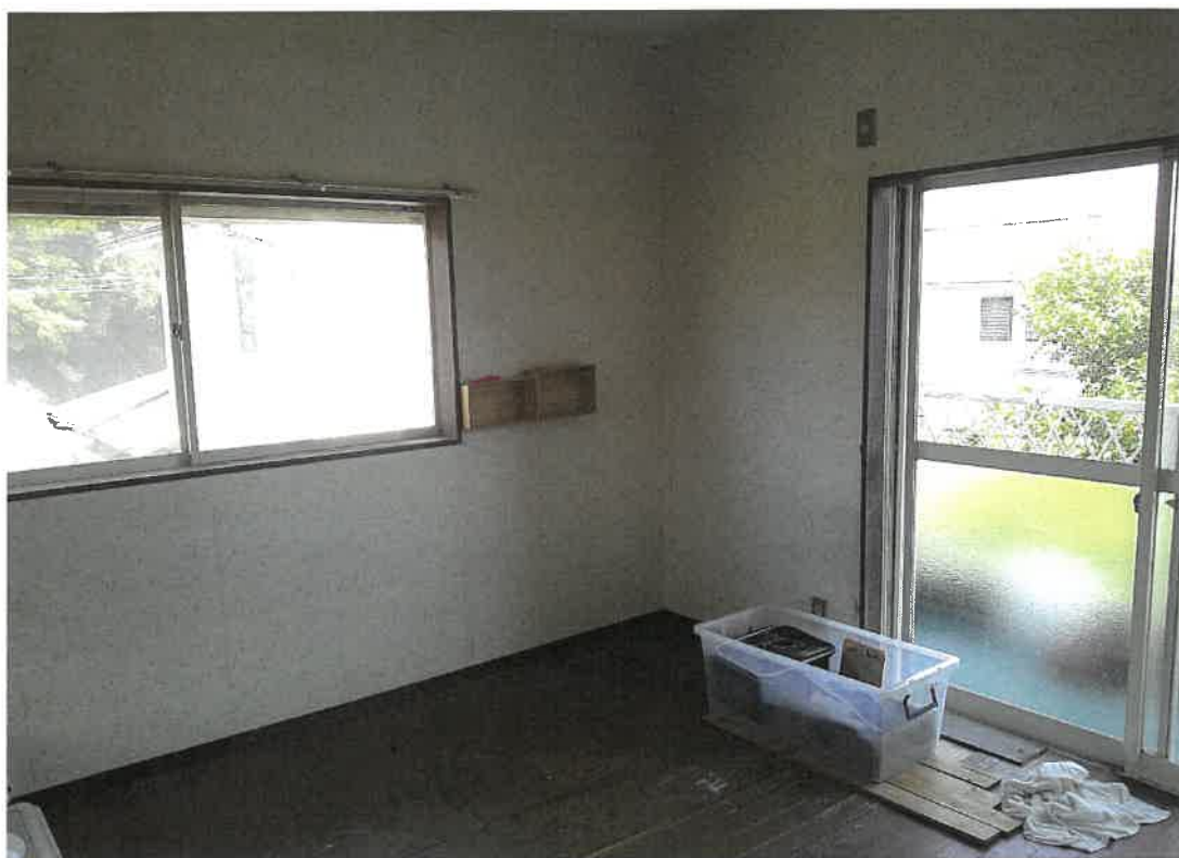
物件 1 2 階内部状況
