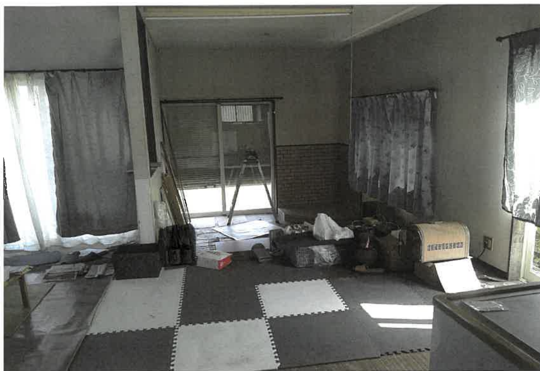
物件1 1階内部状況
