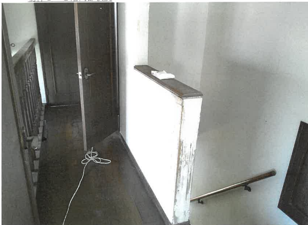
物件 1 2 階内部状況
