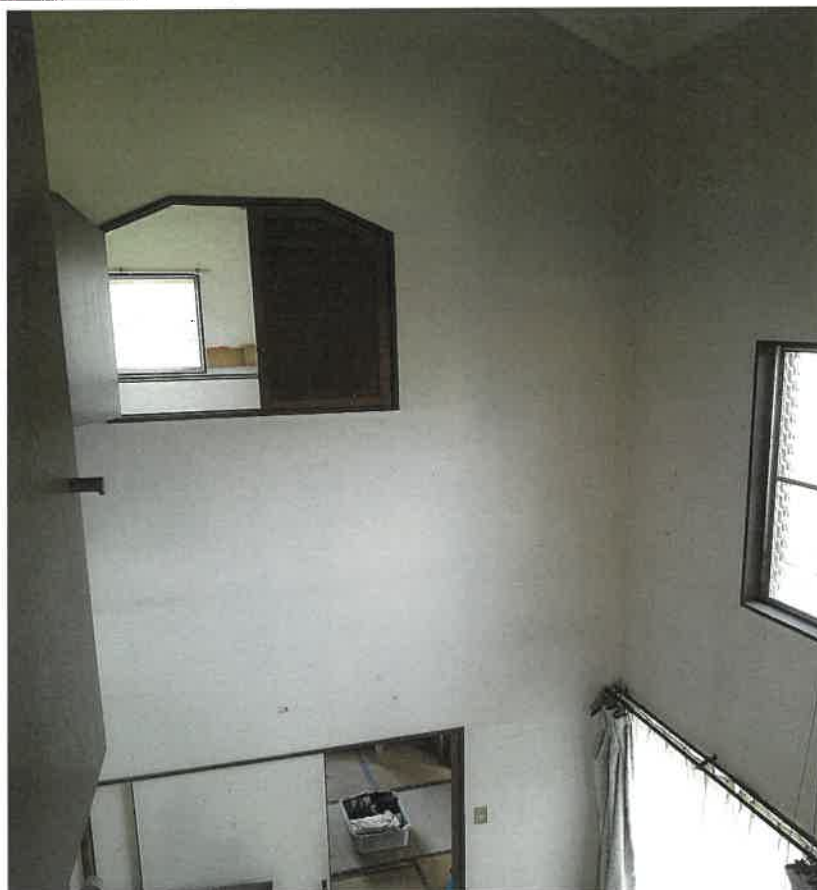
物件 1 2 階内部状況
