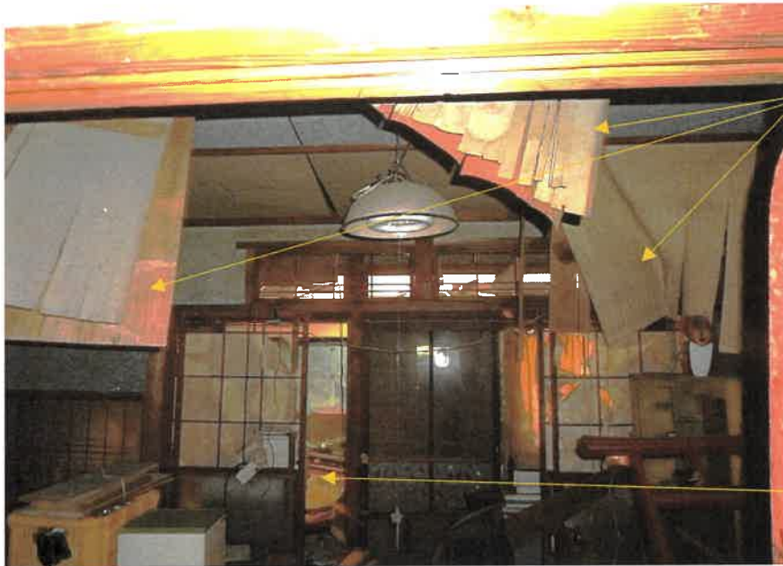
⑭未登記附属建物室内
