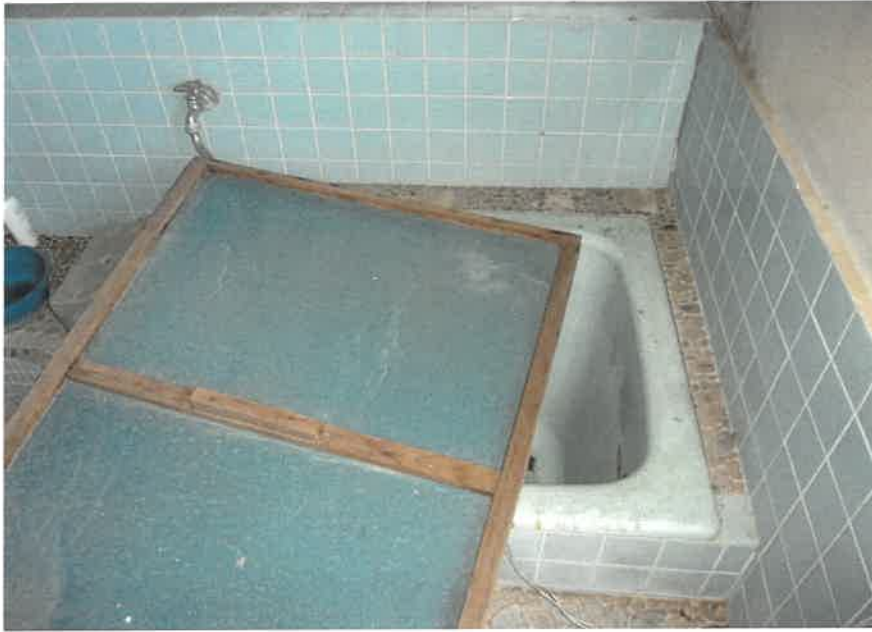
⑬未登記附属建物浴室
