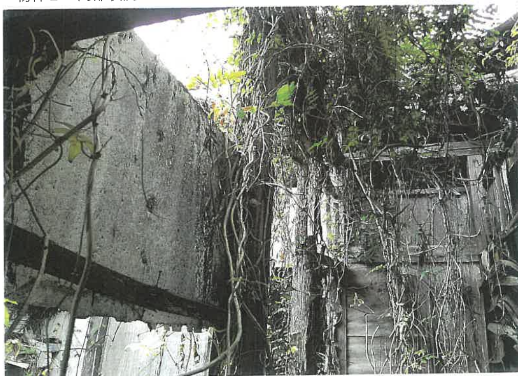
物件 2 内部状況
