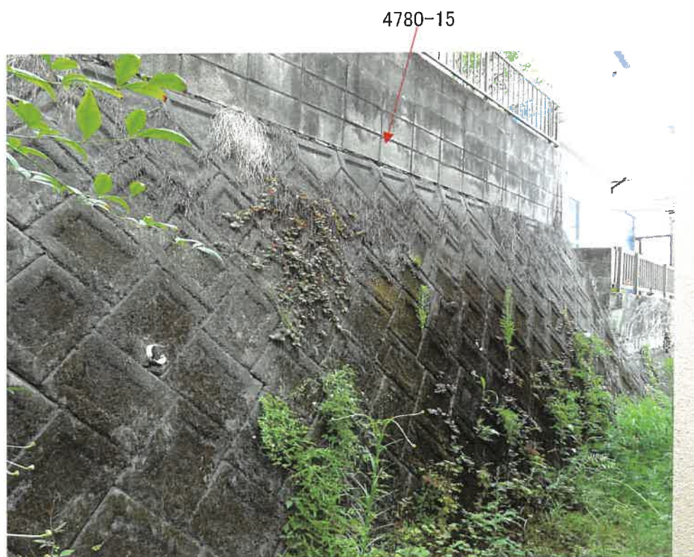
写真3 北側隣接地(4780番15)との高低差の状況
