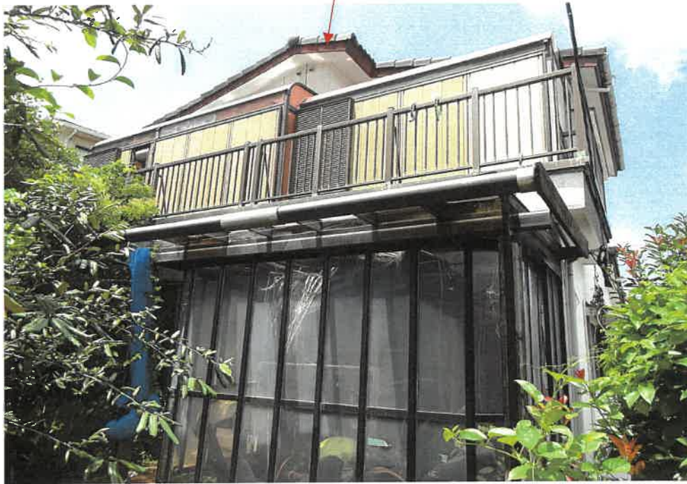
写真8 本件建物内部(1階)
