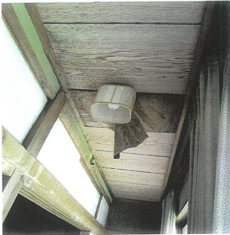
物件 4 内部状況
