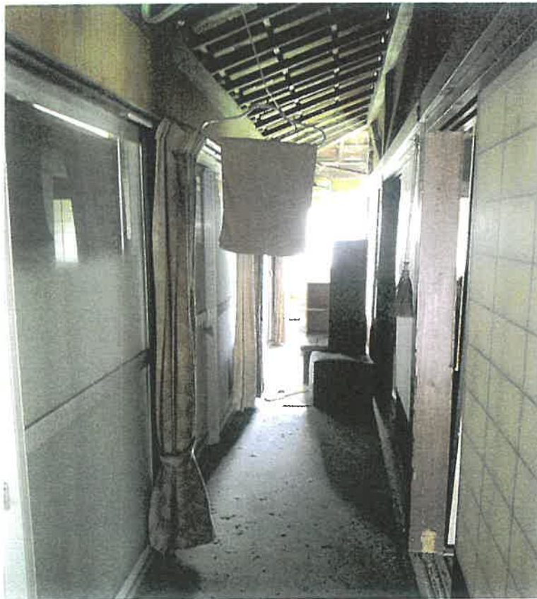
物件 3 内部状況
