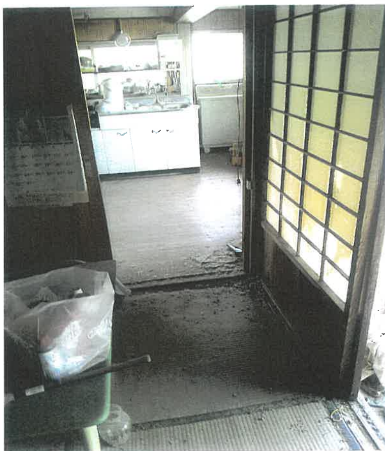
物件3 内部状況
