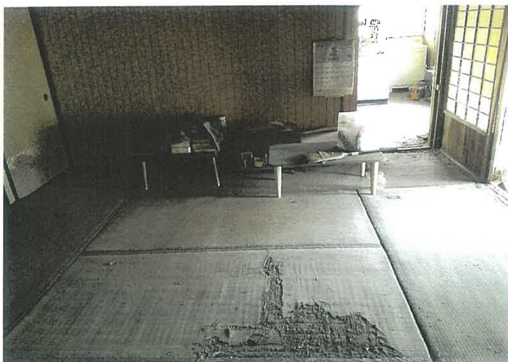
物件 3 内部状況
