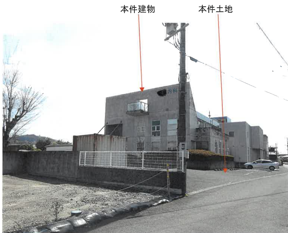
写真1 本件土地建物外観
