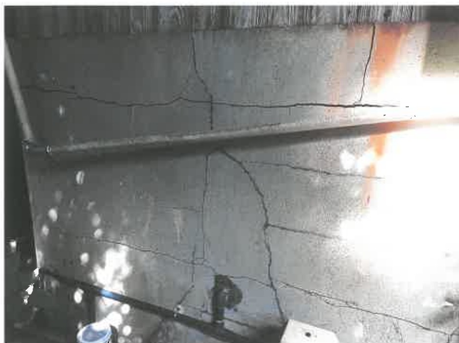
物件4(符号1) 外壁の損傷
