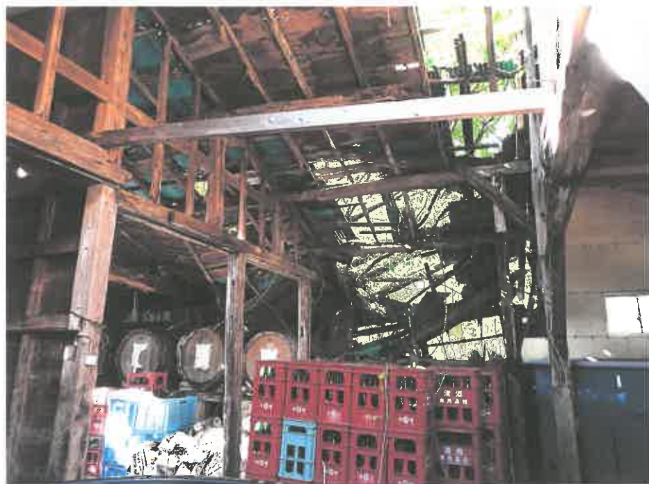
物件 4 (主) 屋根の状況
