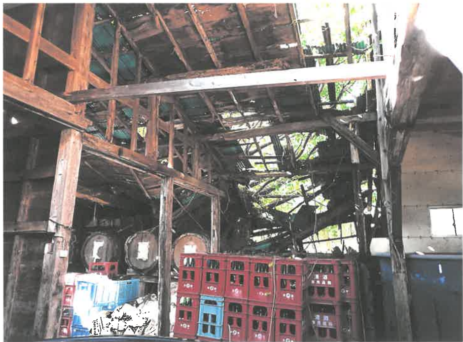
物件 4 (主) 屋根の状況
