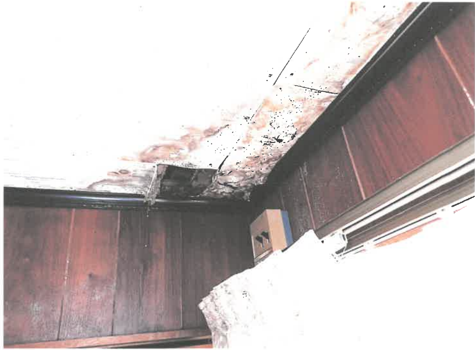
物件 4 (符号 1) 天井の状況
