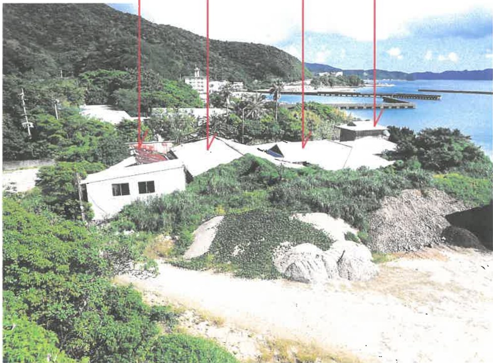
北西方の県道より撮影
