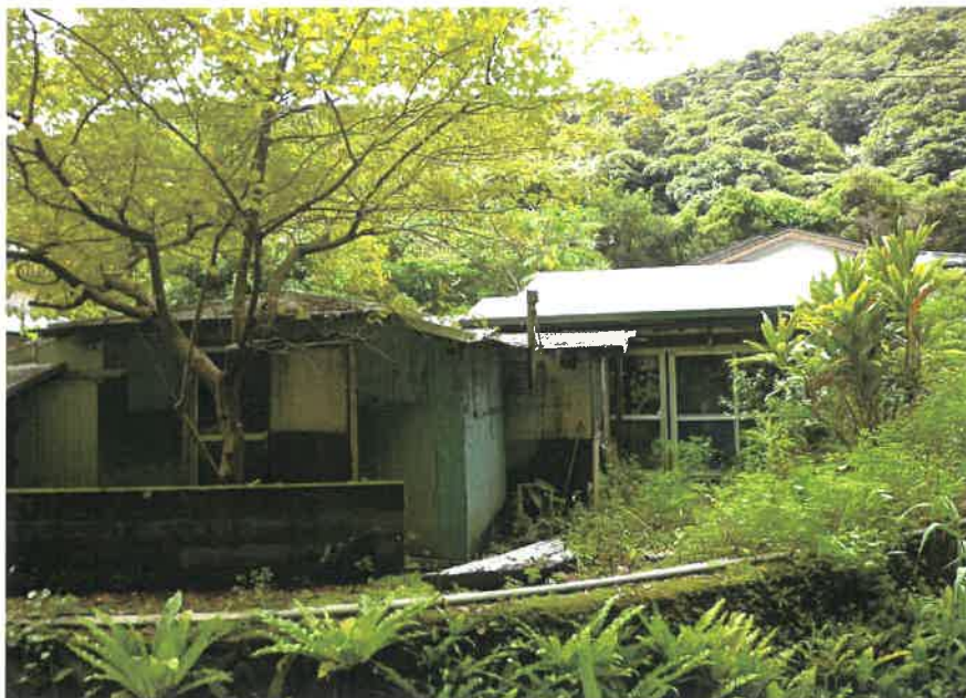
⑦目的外建物 2 (南東)
