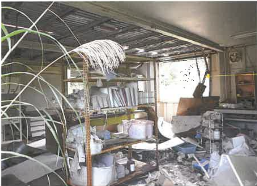
㊹附属建物 2 内部
