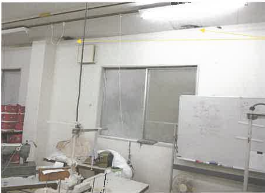
⑪本建物・南東側作業室
