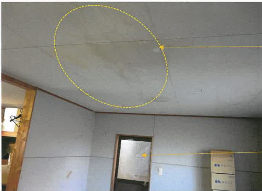
⑪附属建物1天井
