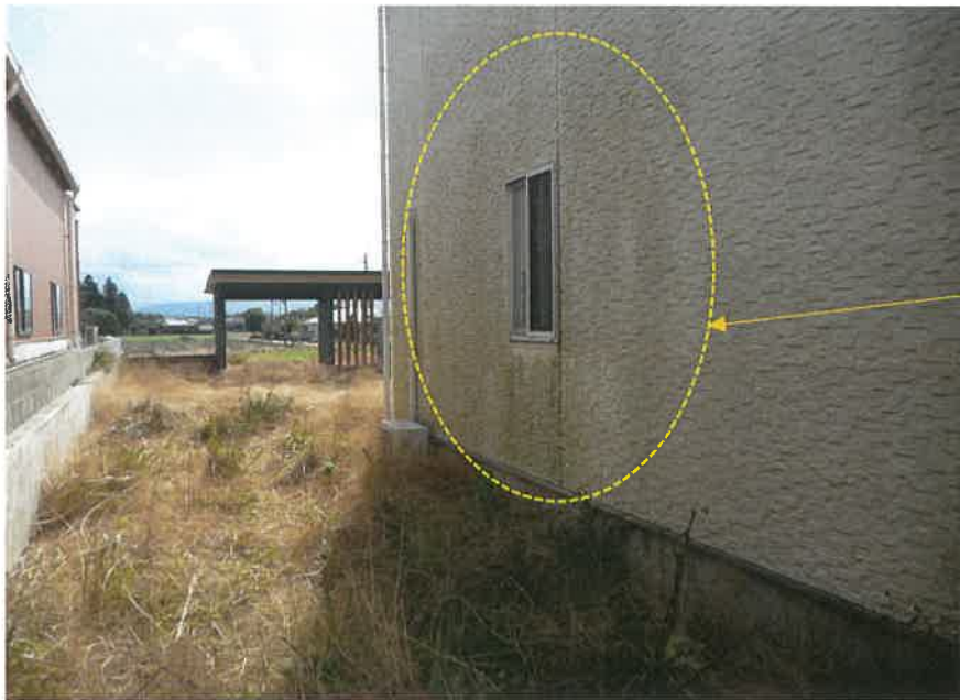
④本建物東側
