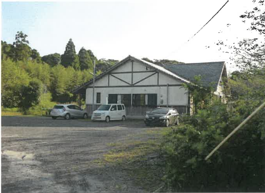
④本建物（西方）
