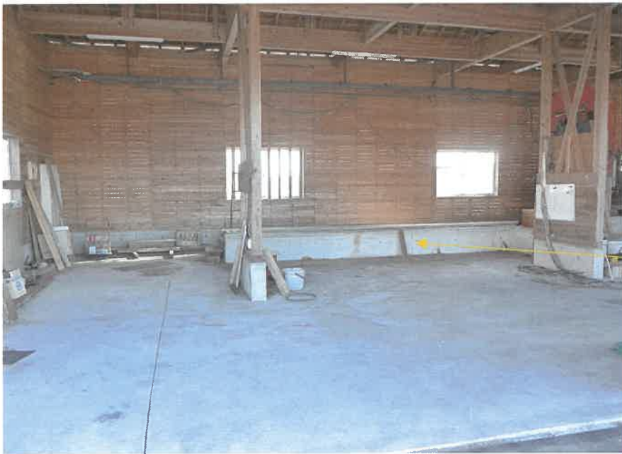
⑩本建物内部
