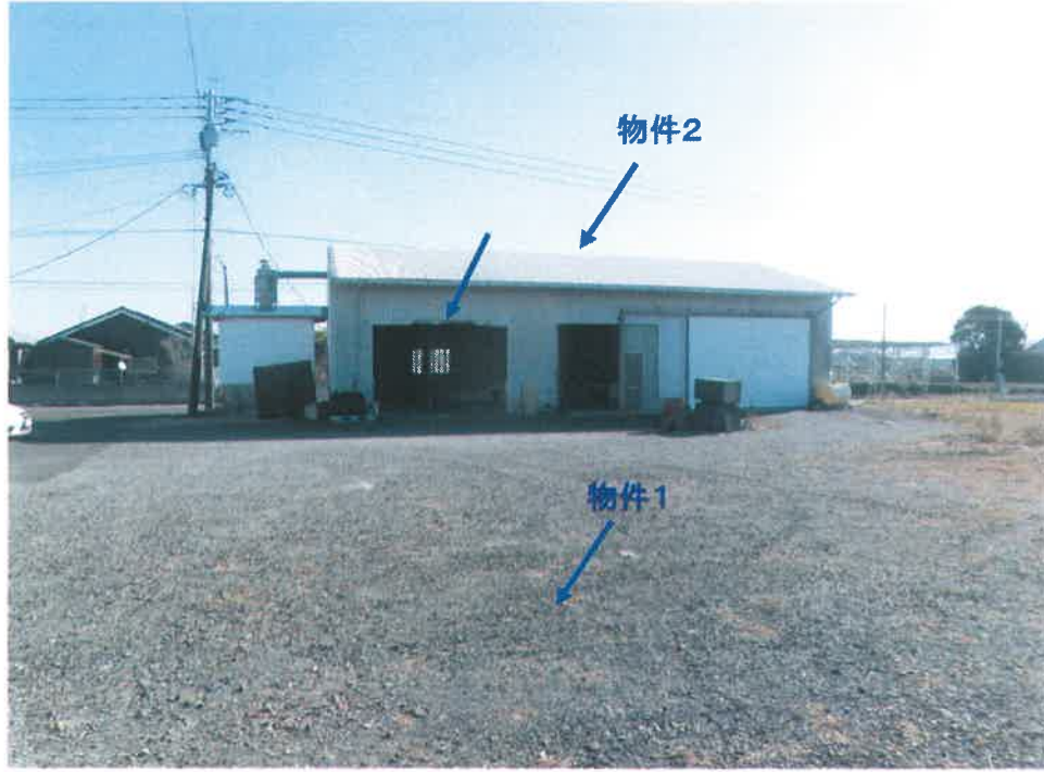
損傷部分の様子
