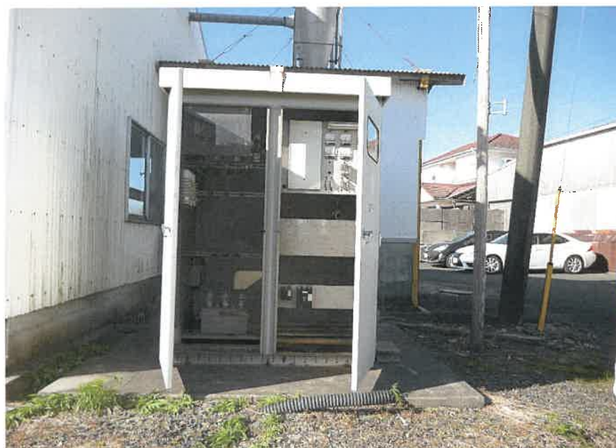
⑥変電設備庫（設備なし）
