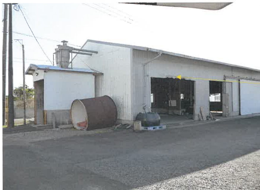
⑨本建物（北西）
