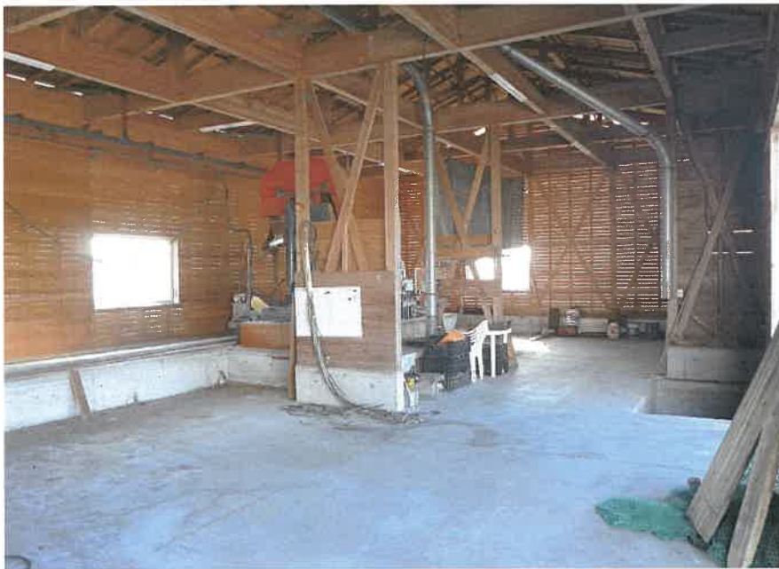
⑪本建物内部
