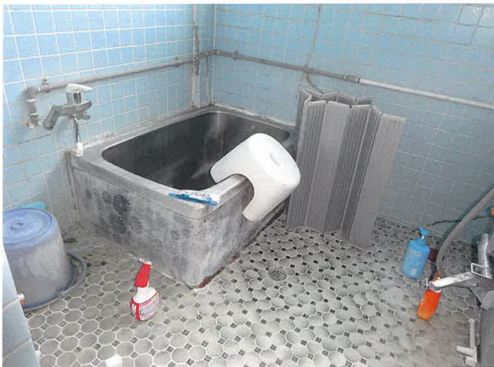
写真12 内壁の傷み
