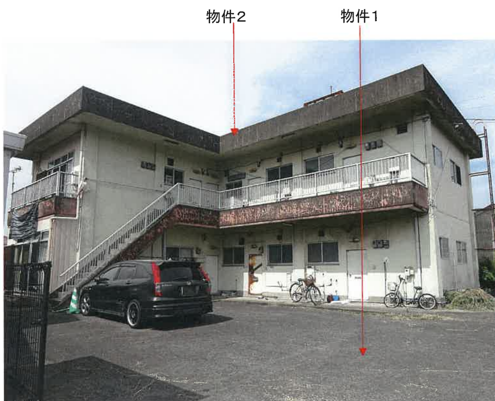
写真2 本件建物外観
