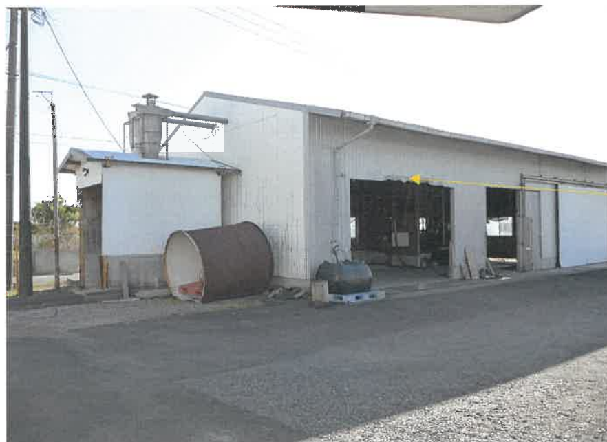
⑨本建物（北西）
