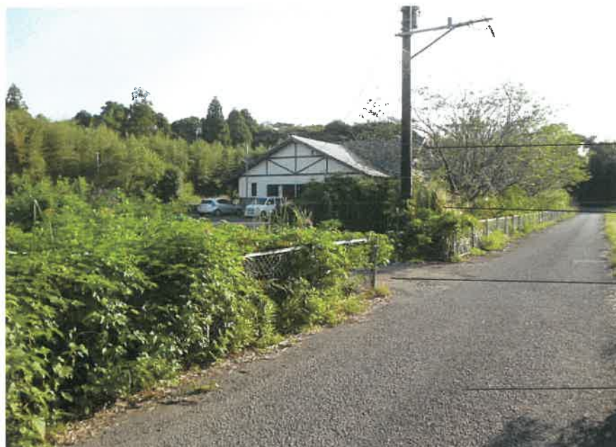
①対象物件全景（南西方）
