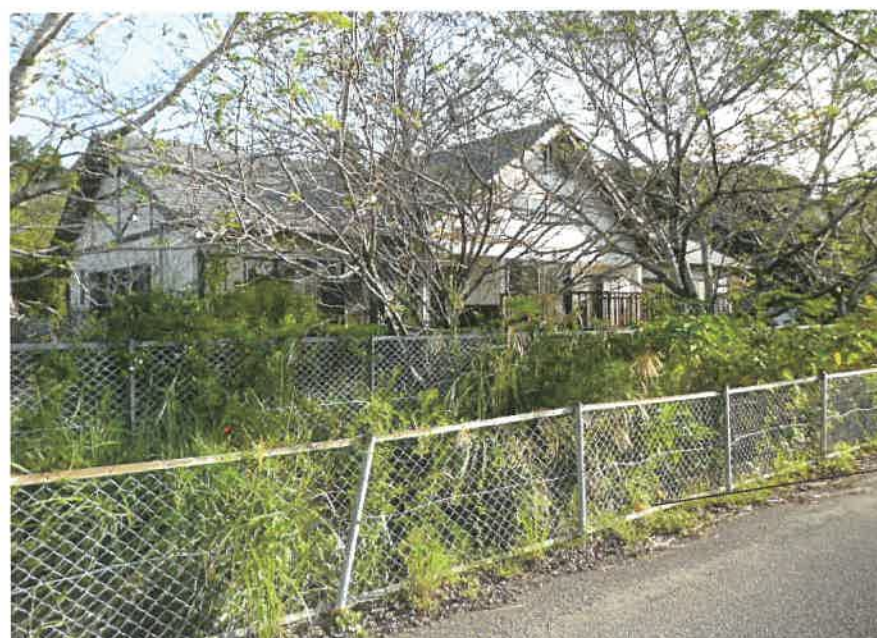
③本建物（南西方）
