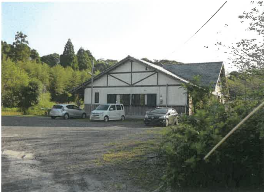
④本建物（西方）
