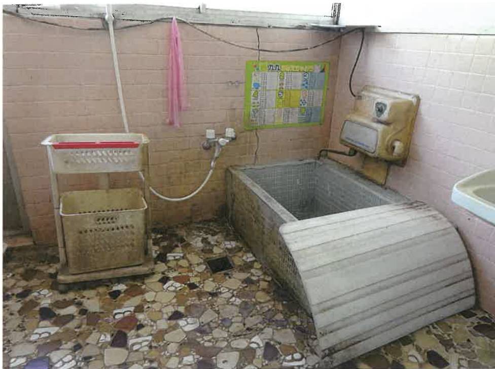
写真16 雨漏り跡と思われる天井の染み
