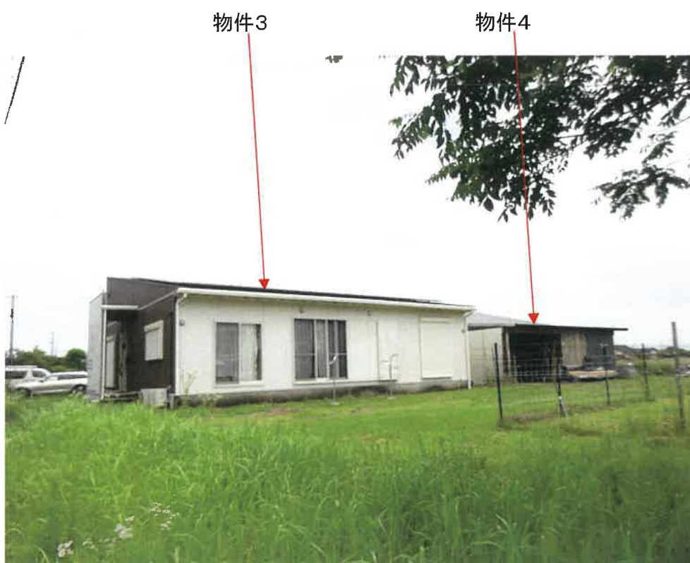
写真1 本件土地建物
