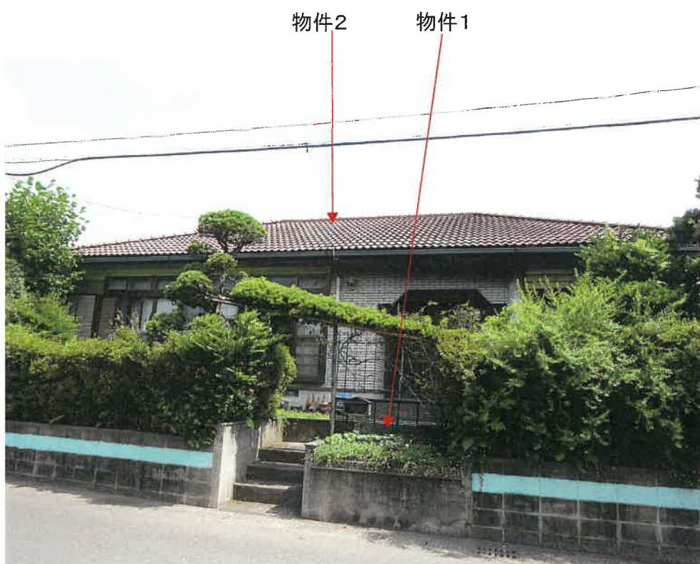
写真1 本件土地建物外観
