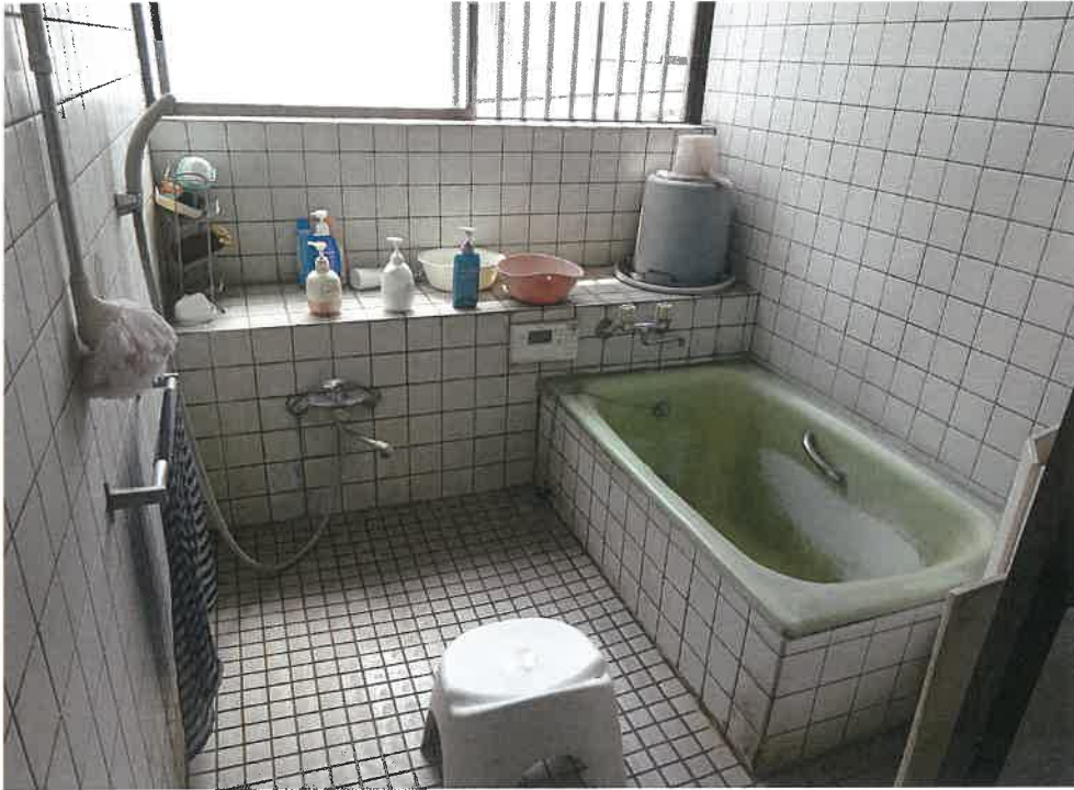
写真12 未登記附属建物内部
