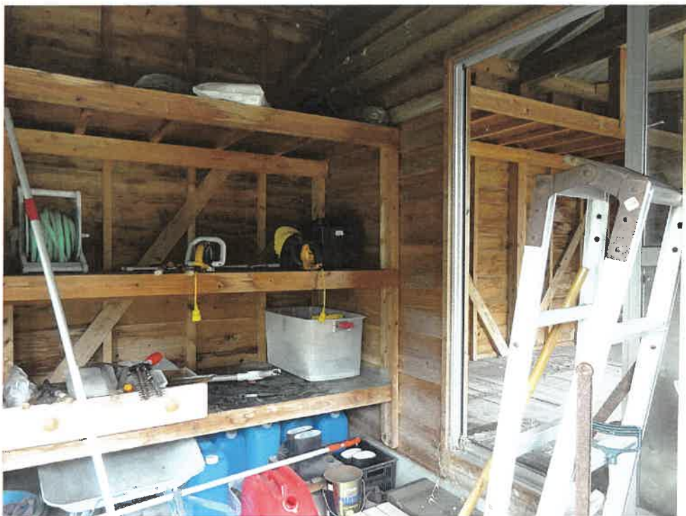
写真16 附属建物符号2内部
