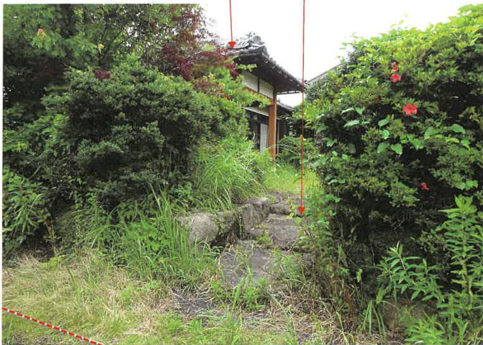
写真6 本件建物外観
