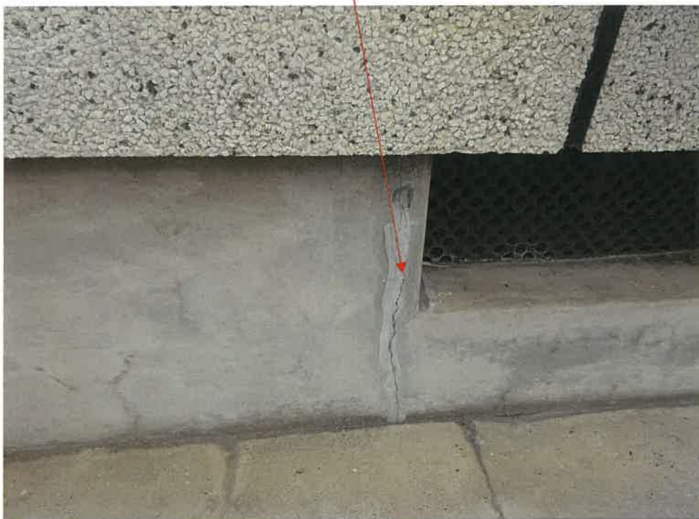
写真6 本件建物内部(1階)
