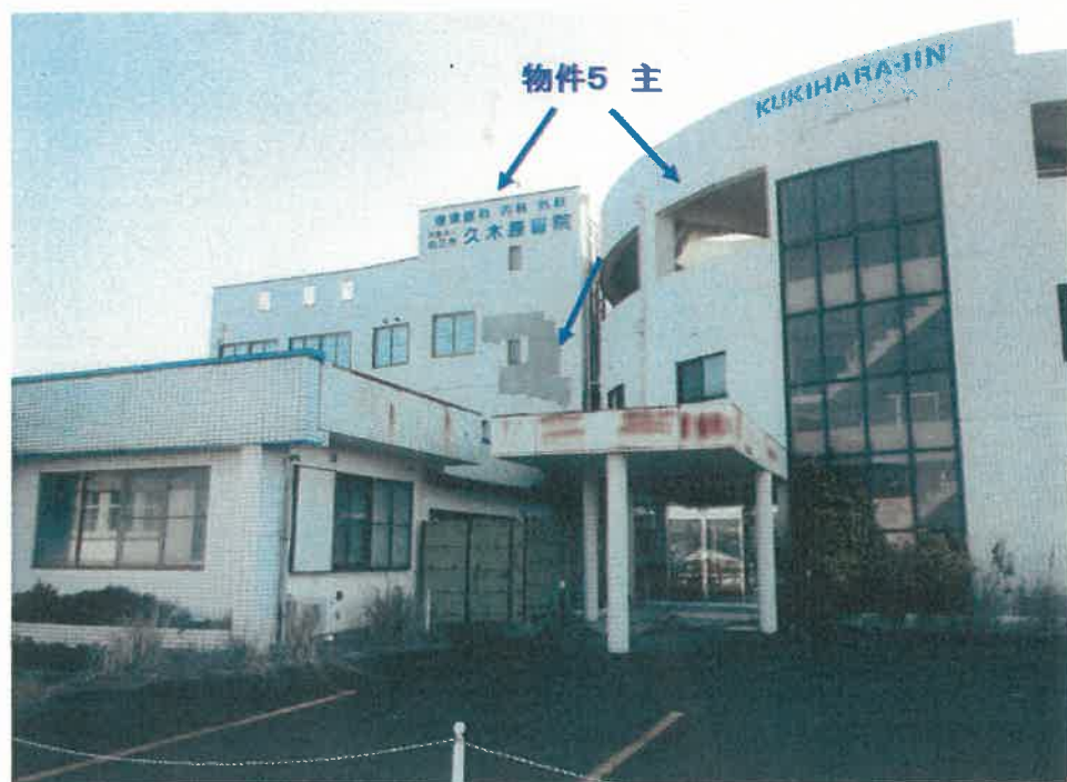
外壁の破損の様子
