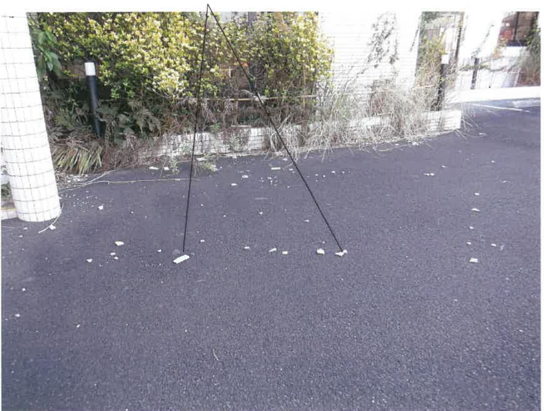
崩落した外壁タイルの残骸
