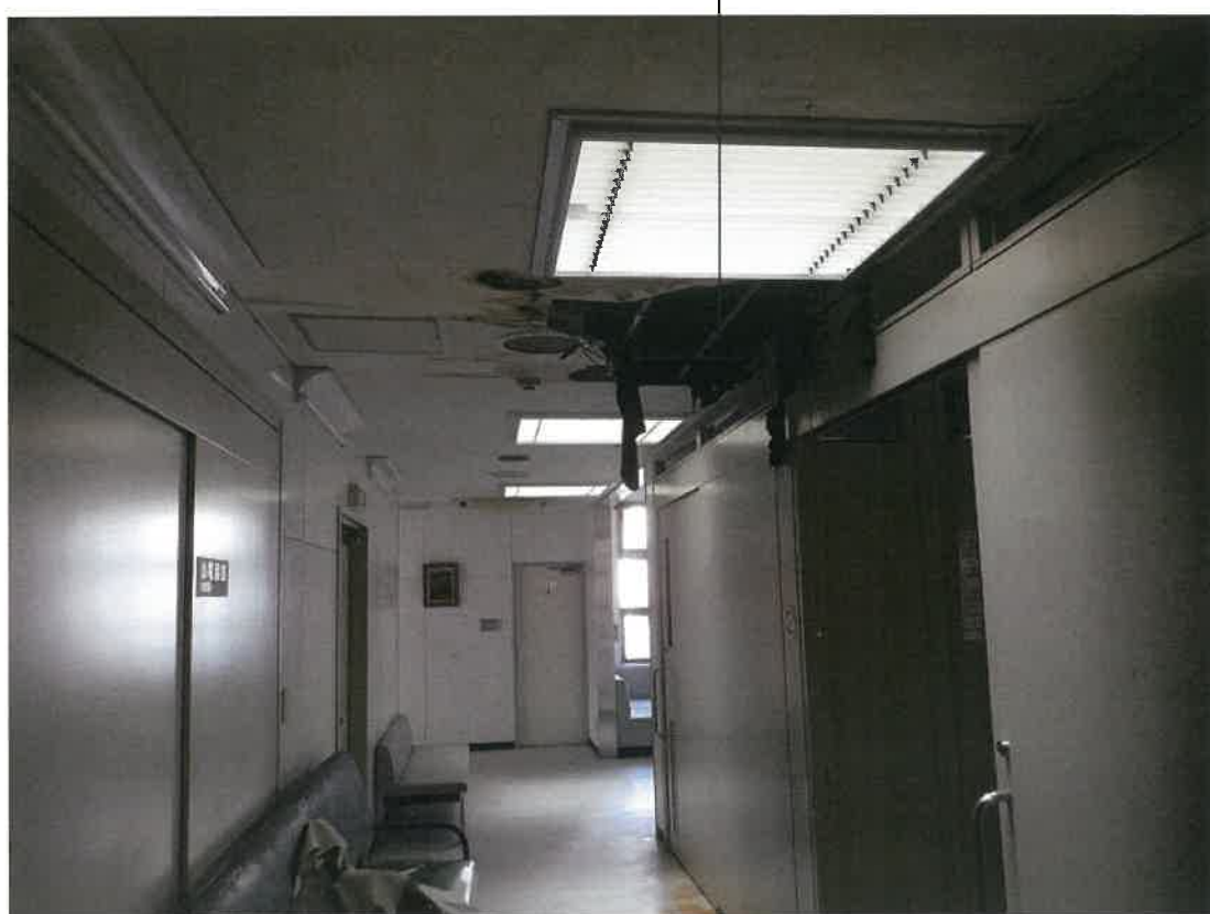
天井が崩落した箇所(雨漏りが原因と思われる)
