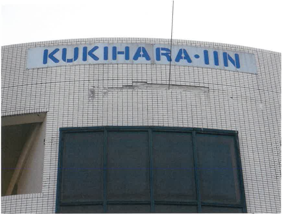
崩落した外壁タイルの残骸
