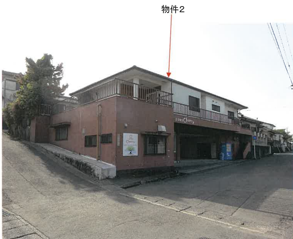
写真1 本件建物外観
