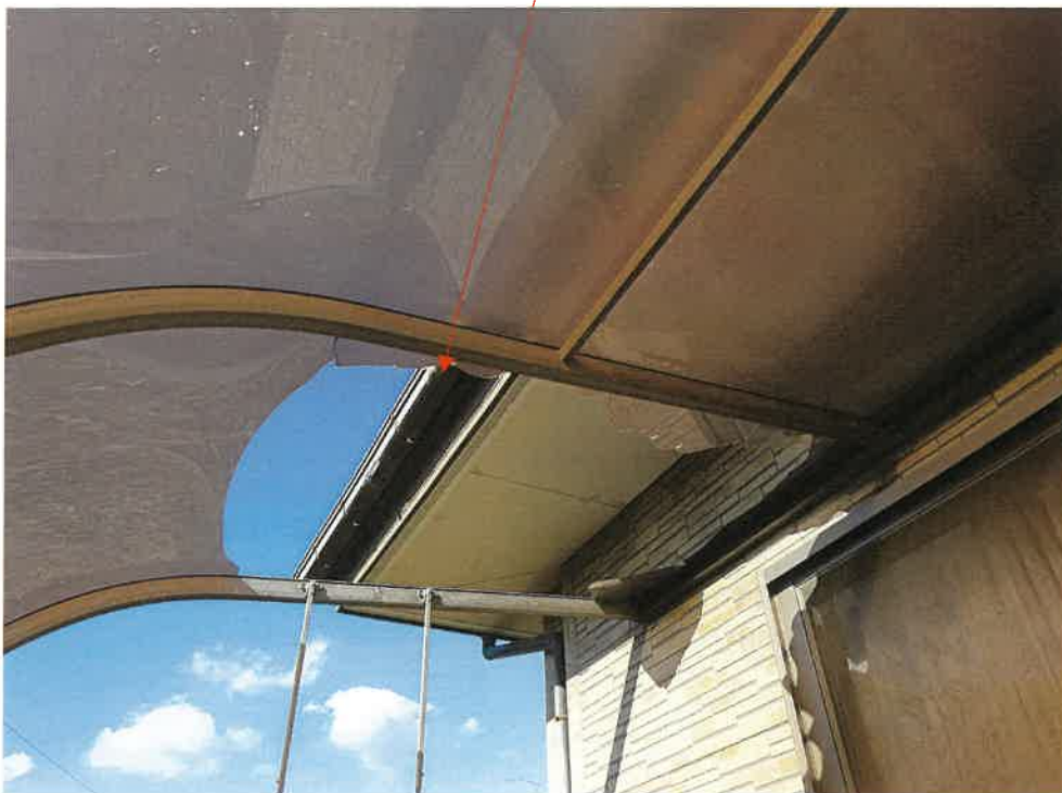
写真6 本件建物内部
