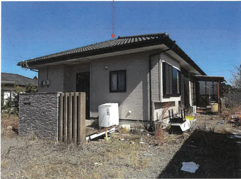
写真4 本件土地に放置された動産類の状況
