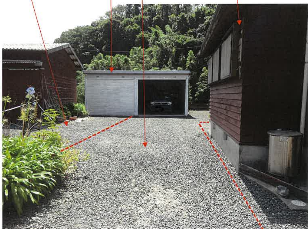
写真2 目的外建物(203番2)の未登記附属建物(車庫) 203-3 物件1 目的外建物(203番2)
