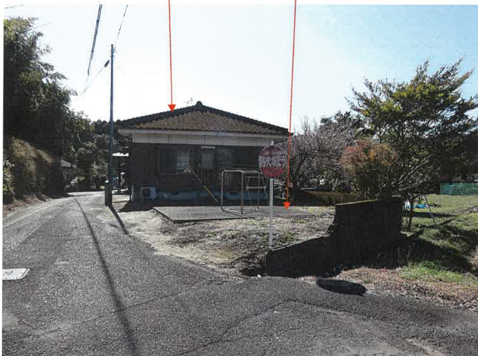
写真2 本件土地に設置されている防火水槽
