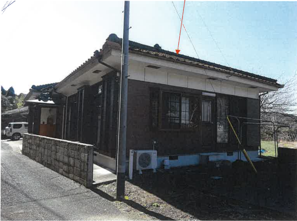
写真4 本件土地上に存する目的外建物
