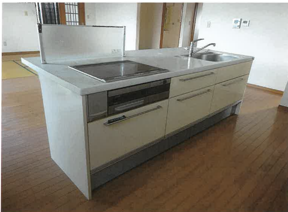
写真16 補修途中で放置された部屋の状況
