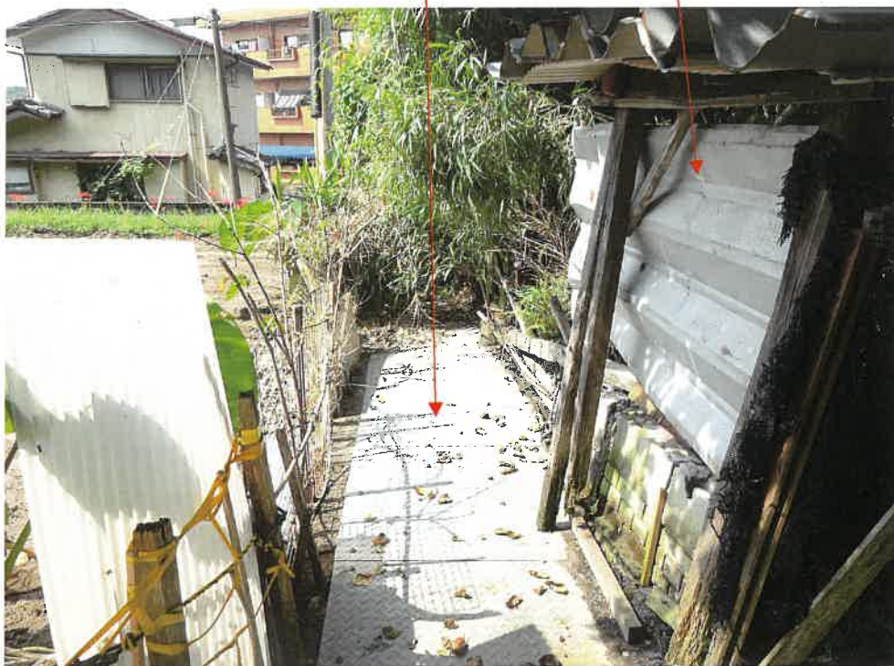
写真8 5168番の土地との境界付近の状況
