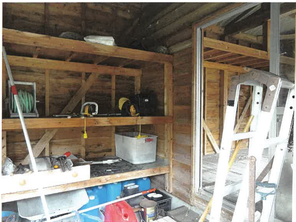
写真16 附属建物符号2内部
