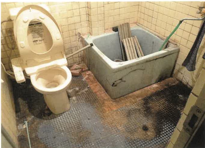
⑫物件 5 トイレ・浴室
