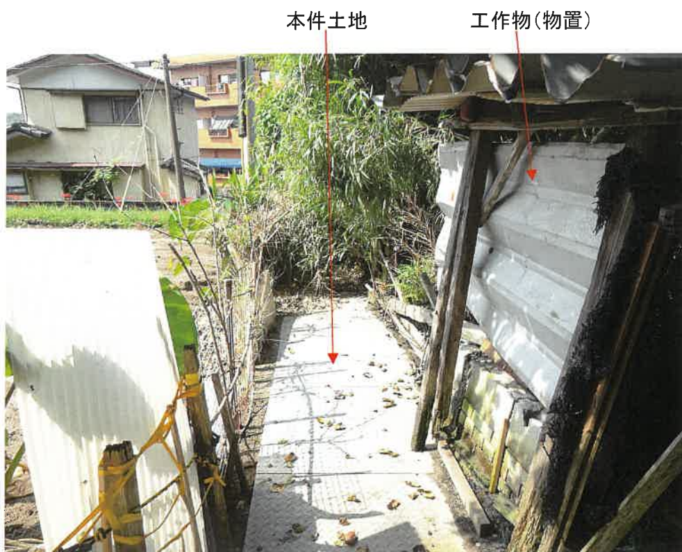
写真7 5168番の土地との境界付近の状況
