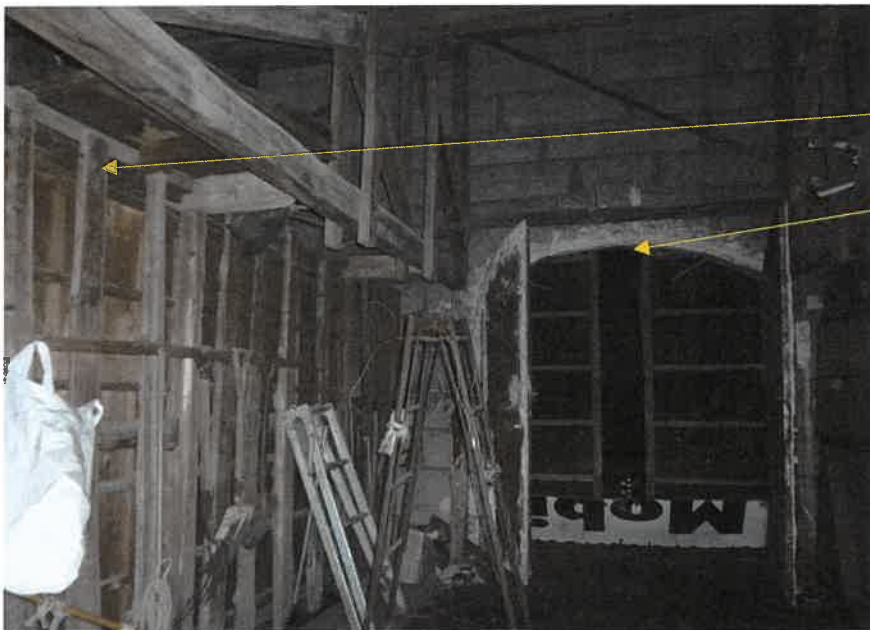
⑧物件 1 6 内部
