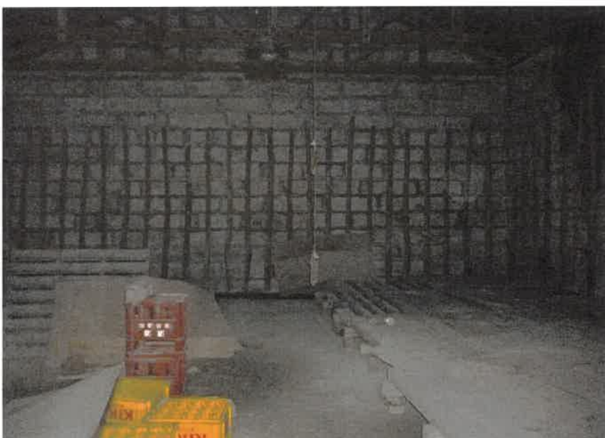
⑨物件 1 6 内部 （奥の倉庫）
