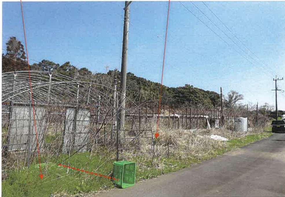
写真8 423-3との境界付近の状況
