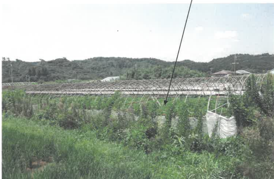
北東方よりのぞむ
