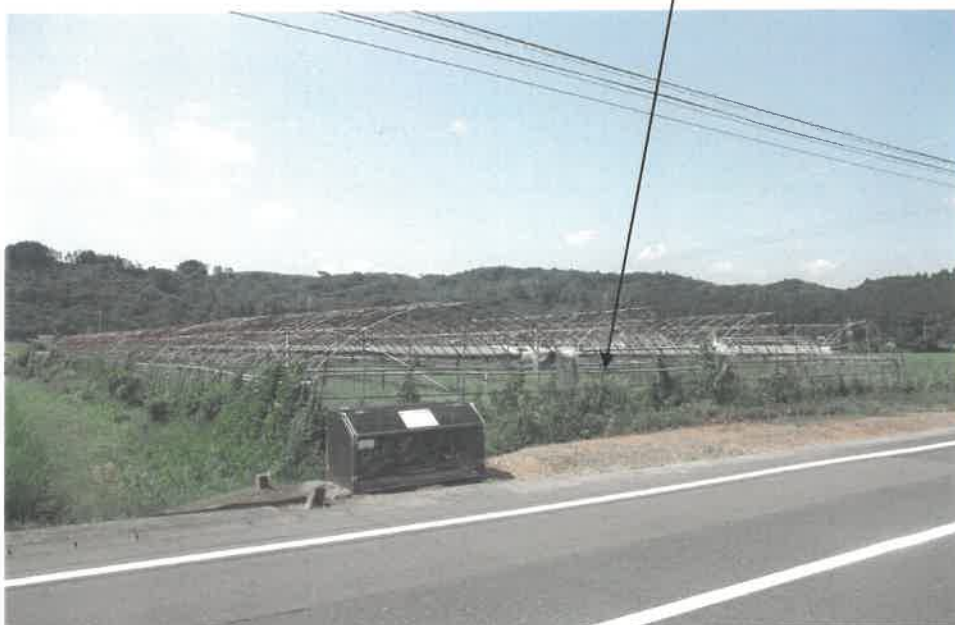
北東方よりのぞむ
