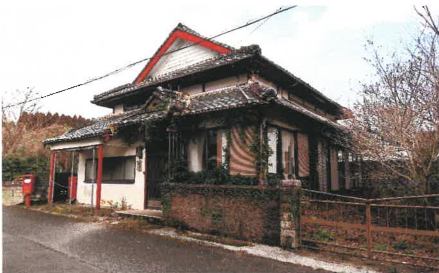
物件 4 建物（南西側）
