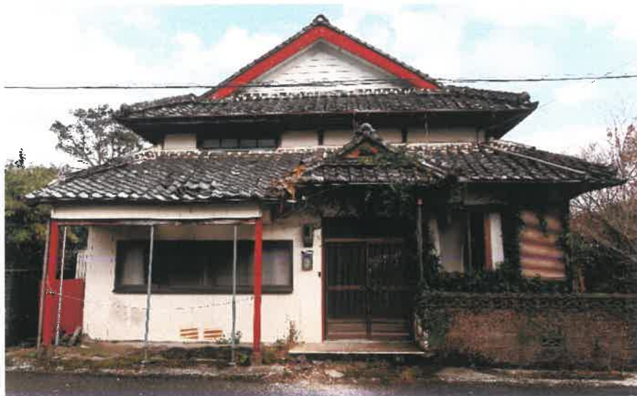
物件 4 建物（北西側）
