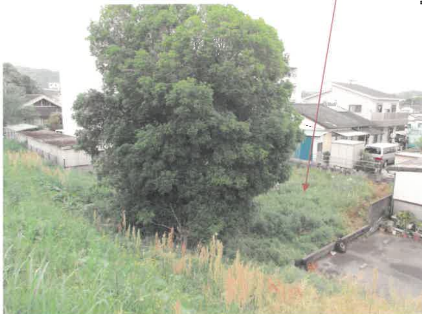
南西方(遊歩道)よりのぞむ
