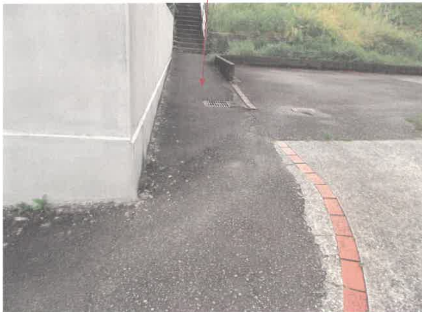
北東方よりのぞむ
