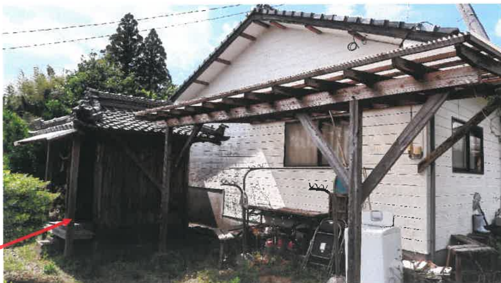
写真③⑦ 物件 5 建物 (南側) 祠
