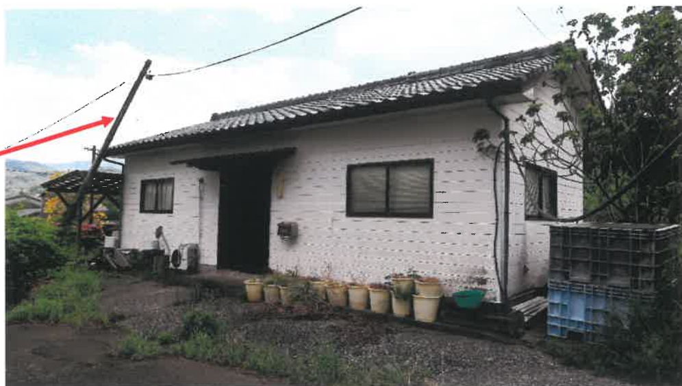
物件 5 建物 (北西側)
