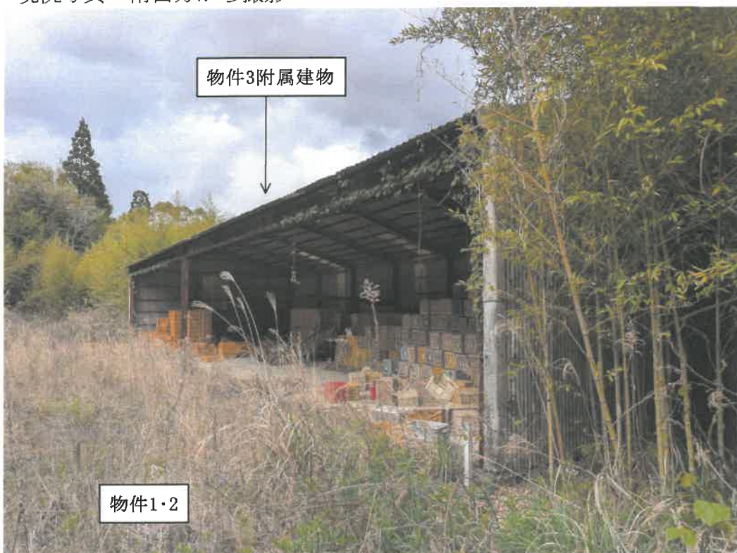
現況写真 南西方から撮影
