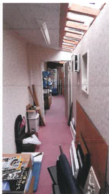
増築部分 内の状況
