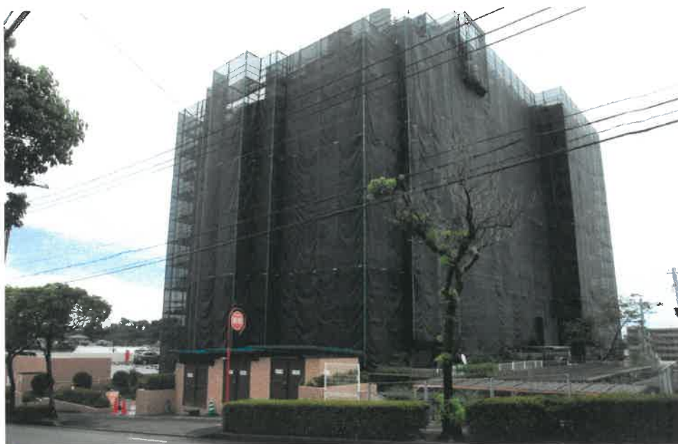
一棟の建物 北西方よりのぞむ
