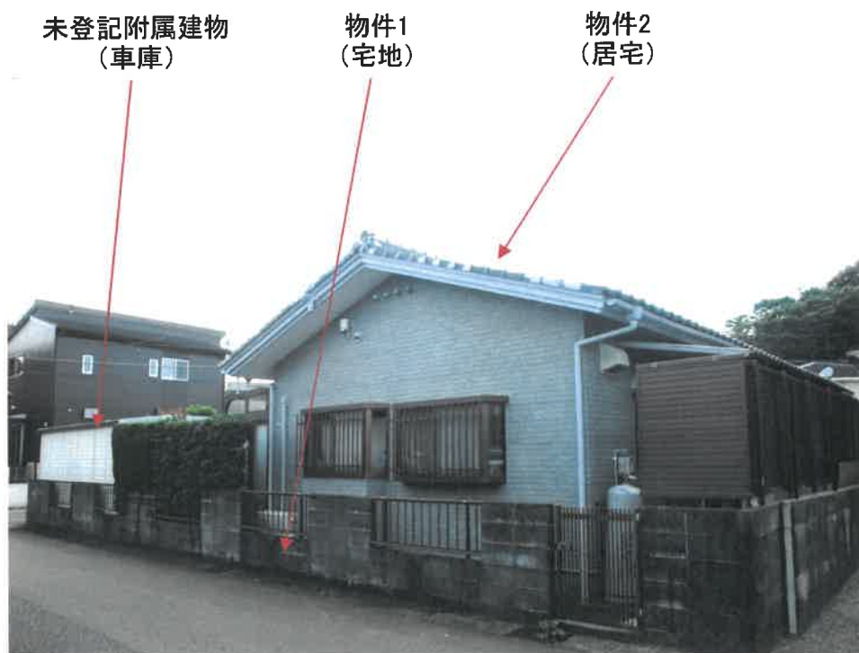
北西方よりのぞむ
