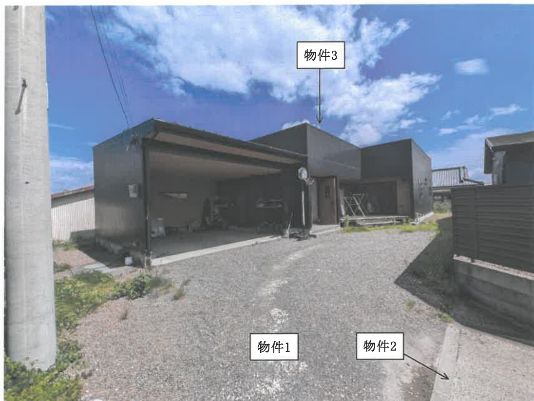
現況写真 南東方から撮影
