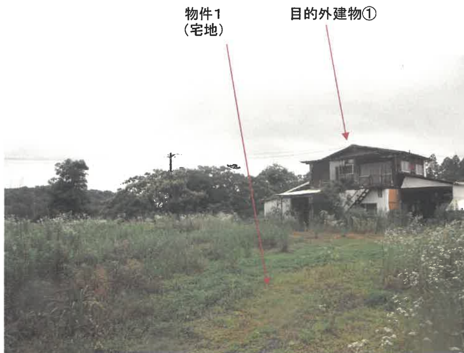
北東方より物件1をのぞむ
