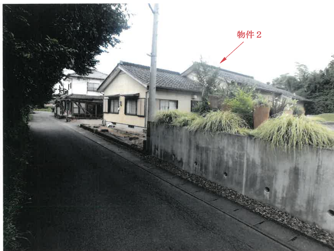
北東方より撮影
