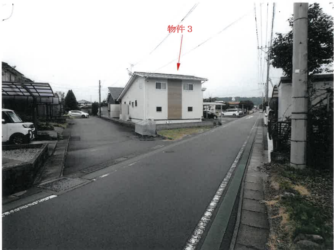
北東方より撮影
