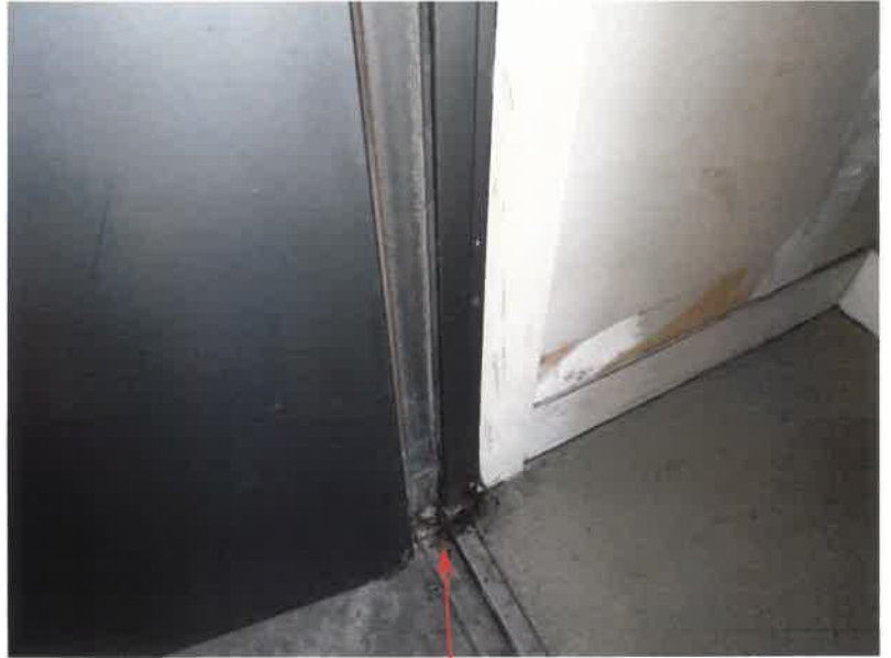
錆で腐食した箇所
