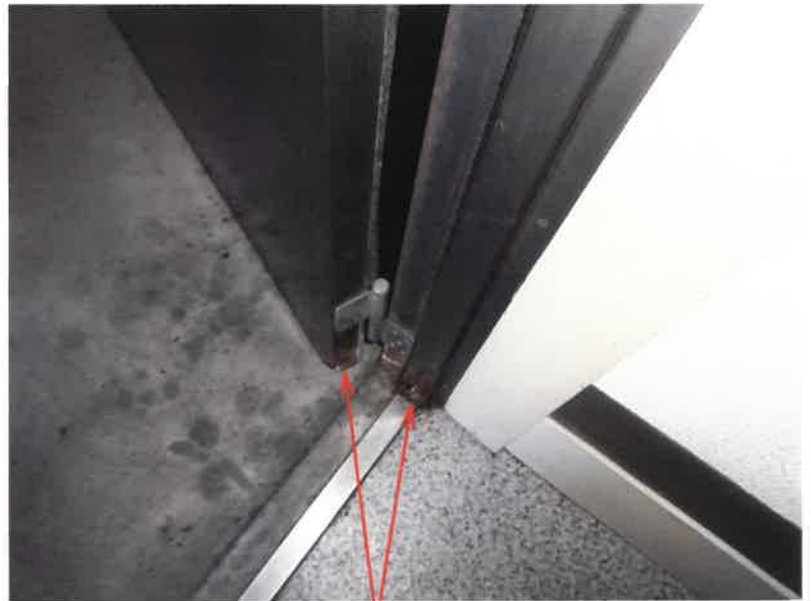
錆で腐食した箇所
