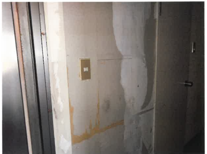
錆で腐食した箇所
