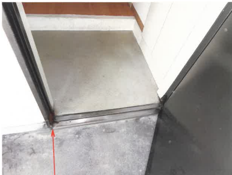
錆で腐食した箇所
